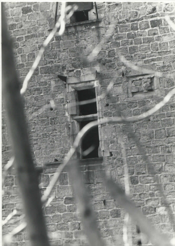
Aile Est Fenêtre à meneaux en partie bouchée
