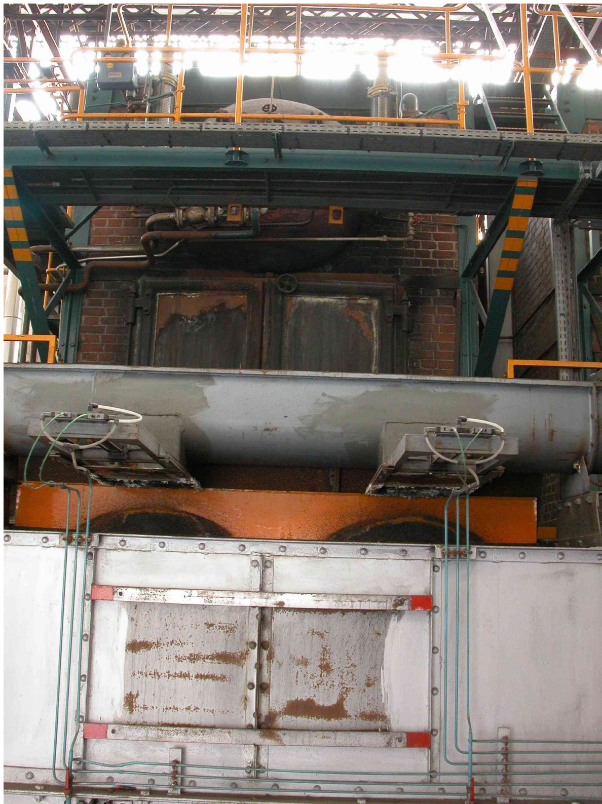
Fig.24 Bâtiment de la chaufferie : chaudières Babcock et Wilcox installées en 1939, détail.
