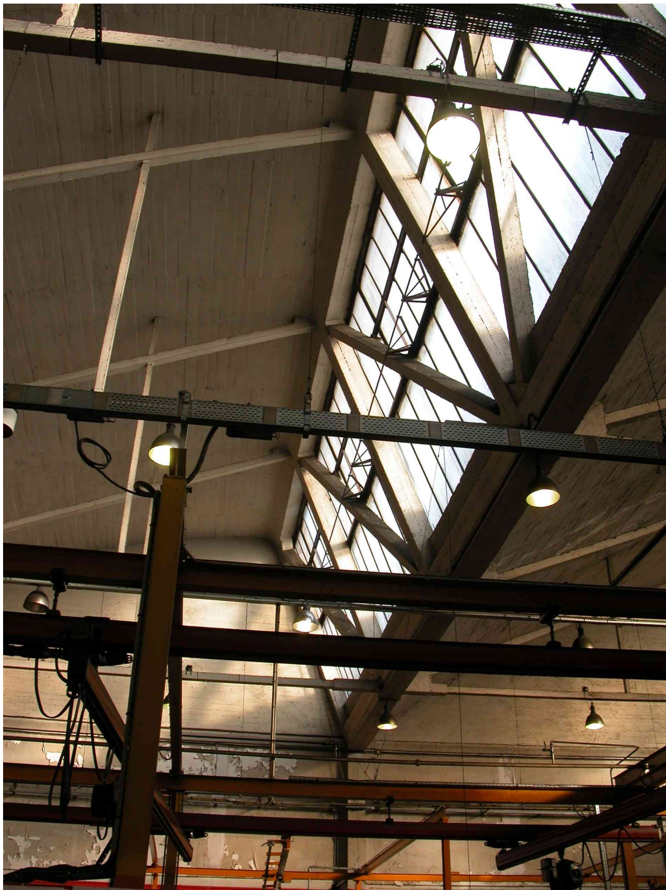
Fig.57 Vue intérieure des ateliers (sheds en béton armé).
