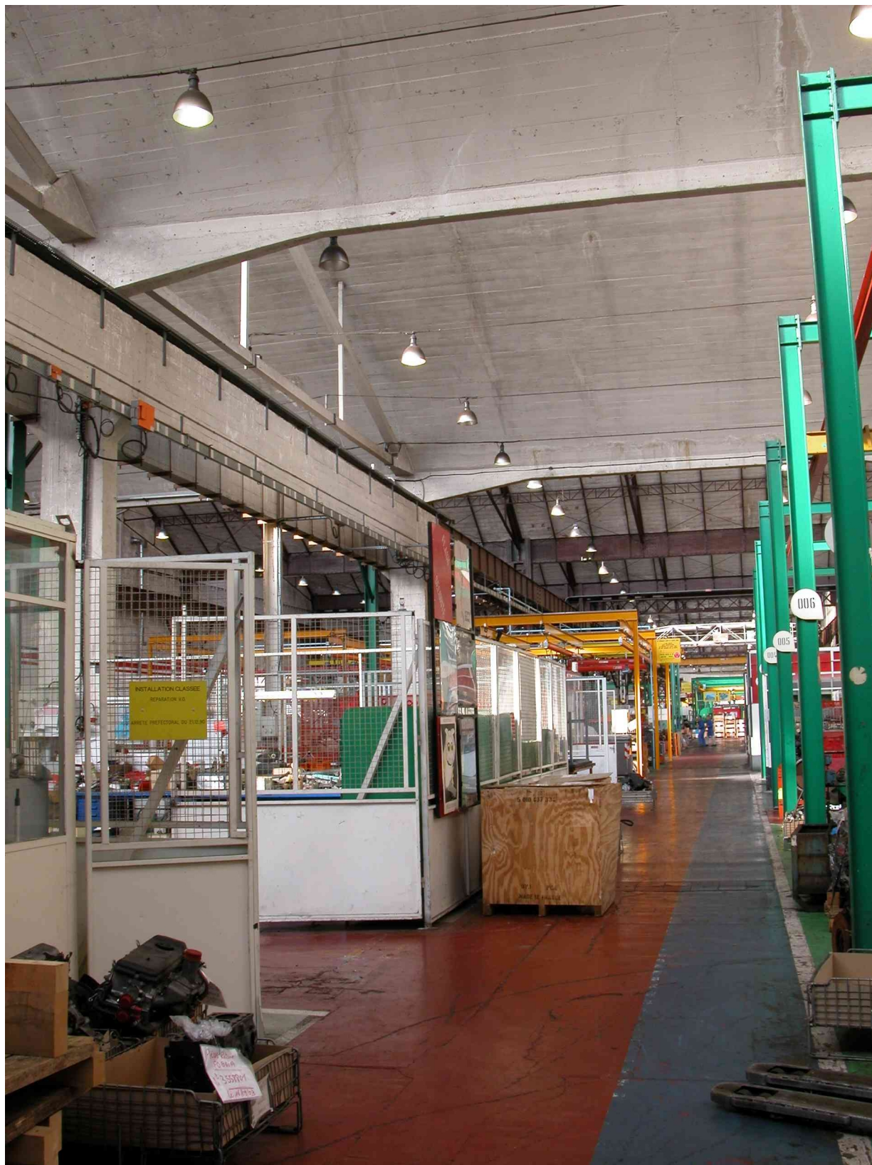
Fig.61 Vue intérieure des ateliers : sheds en béton au premier plan, en métal au second plan.
