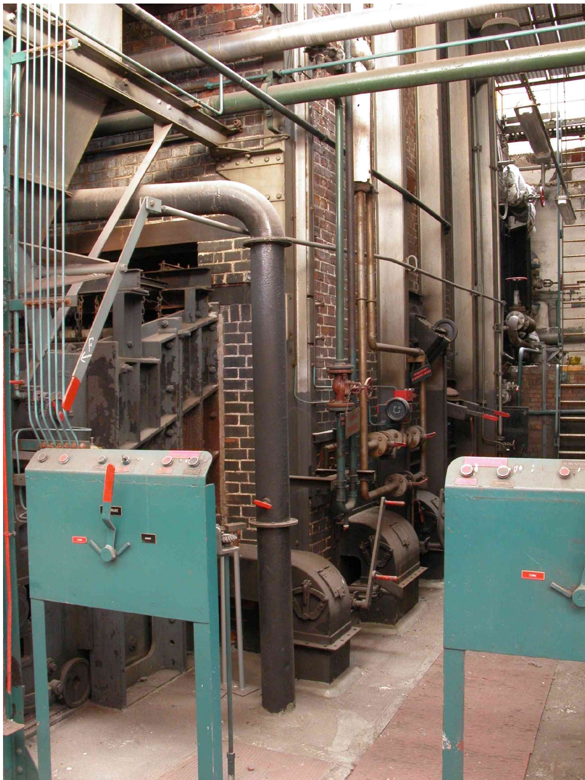
Fig.23 Bâtiment de la chaufferie : chaudières Babcock et Wilcox installées en 1939.
