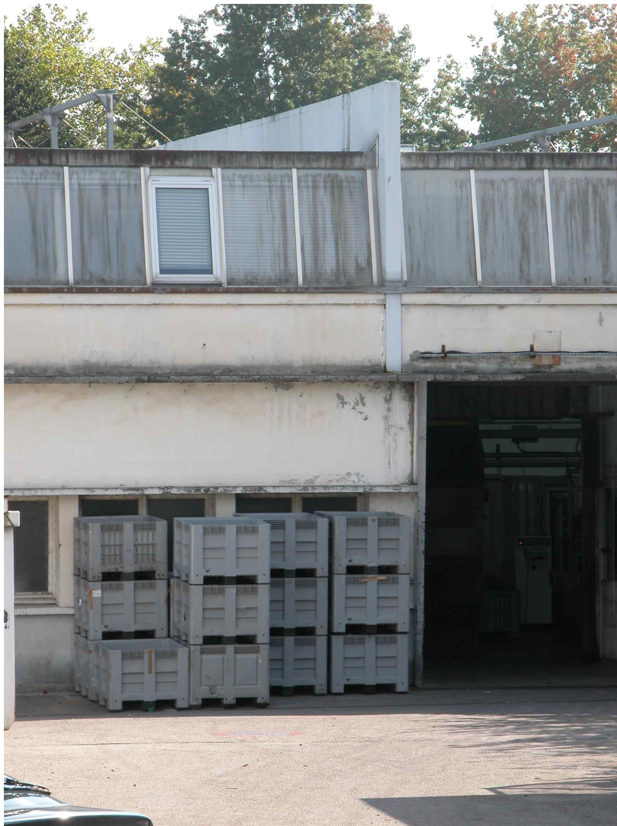
Fig.5 Détail de la façade des ateliers construits en 1962 : on distingue nettement les portiques supportant la charpente.
