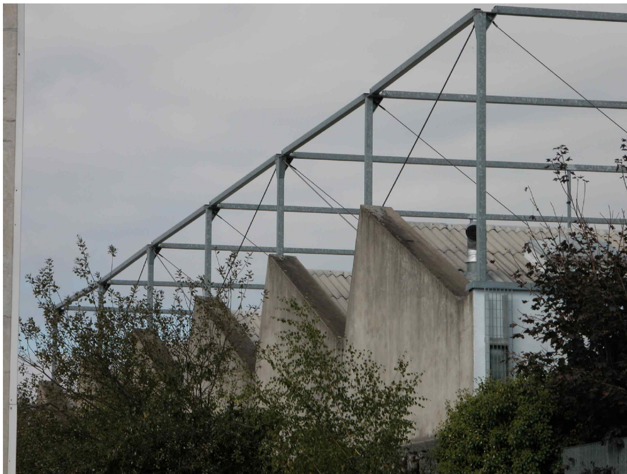
Fig.3 Détail des sheds et de la structure porteuse des anciens magasins d'expédition (vue depuis l'avenue du Maréchal De Lattre de Tassigny).
